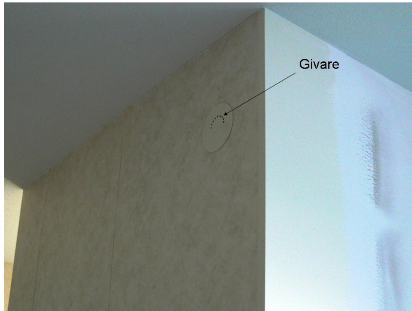
Figur 3. Placering av givare som mäter temperatur och relativ luftfuktighet 2 m ovanför golvet mellan kök och hall.
