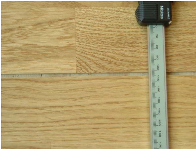
Figur 15. Största springan 3,1 mm i anslutning till fönsterpartiet i vardagsrummet.
