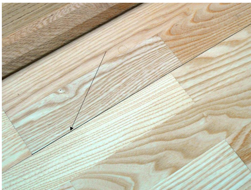
Figur 9. Springa i lamellparkettgolvet i köket intill öppningen mot vardagsrummet. Föroreningar som samlas i springan gör att den framträder tydligare med tiden.
